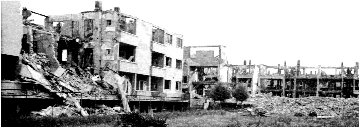
Schwer beschädigter F-Block an der Idsteiner Straße, hier die Rückseite. Hinten die zerstörten nordöstlichen Zeilen der Idsteiner Straße (Foto: © Karl Hergt)
