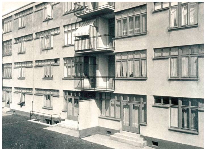
Gartenseite Schneidhainer Str. 1-16 — nach außen öffnende Fenster, 1930 7
