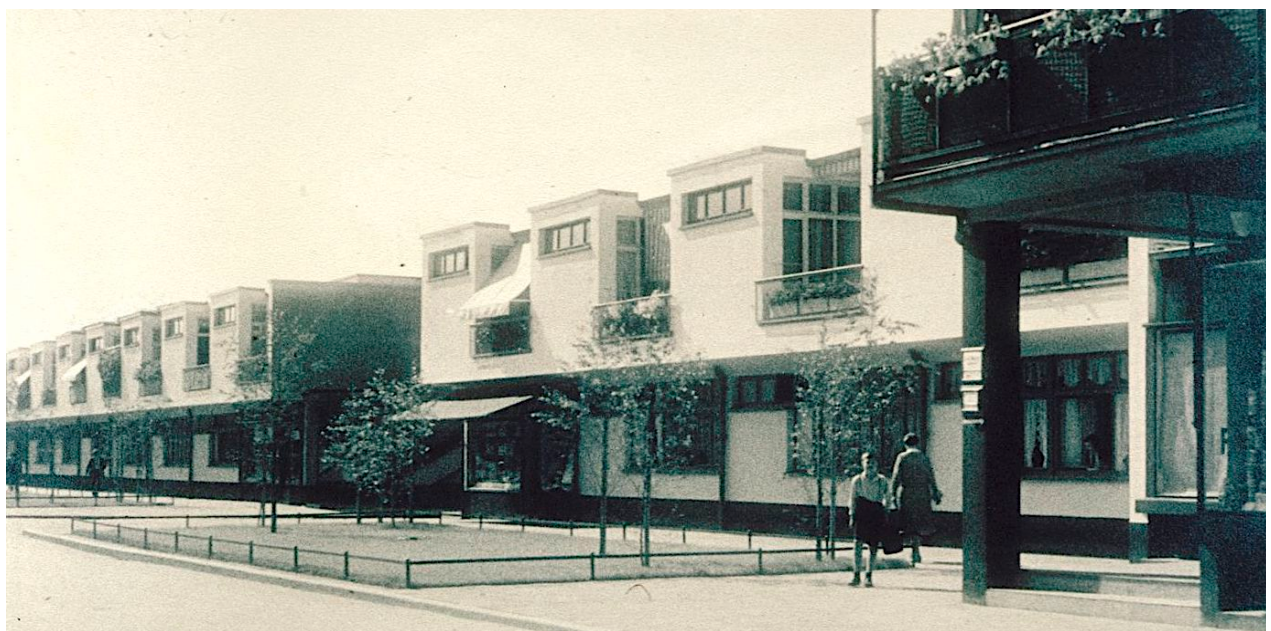
Kopfbauten an der Frankenallee, 1929 7
