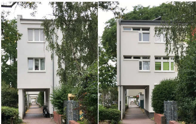
Heute: Kopfbauten Idsteiner Straße, rechts weitgehender Originalzustand, links nach Zerstörung verändert wiederaufgebaut (Fotos: privat)
